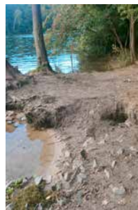
Tiefe Wühlschäden zerstören das Ufer – auch die Aufenthaltsqualität ist erheblich eingeschränkt.
